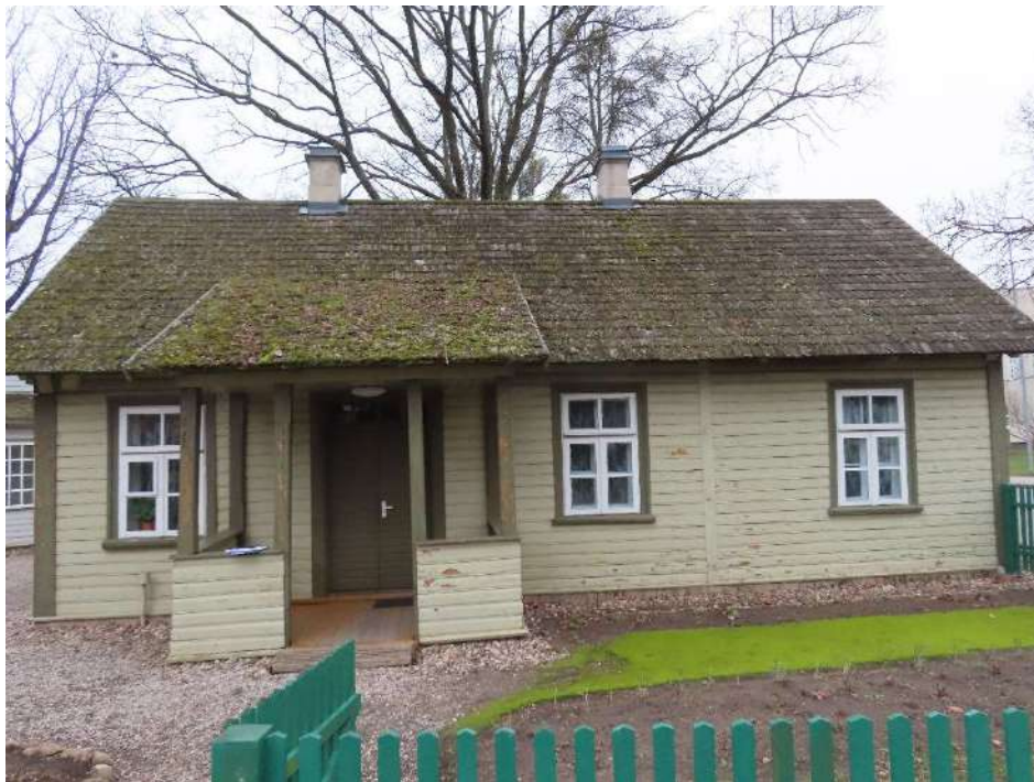
14. Mikalojaus Konstantino Čiurlionio sodybos namo rytinės pusės fasadas. Fasada apkalti medinėmis dailylentėmis, dažai vietomis atsisluoksniavę.
