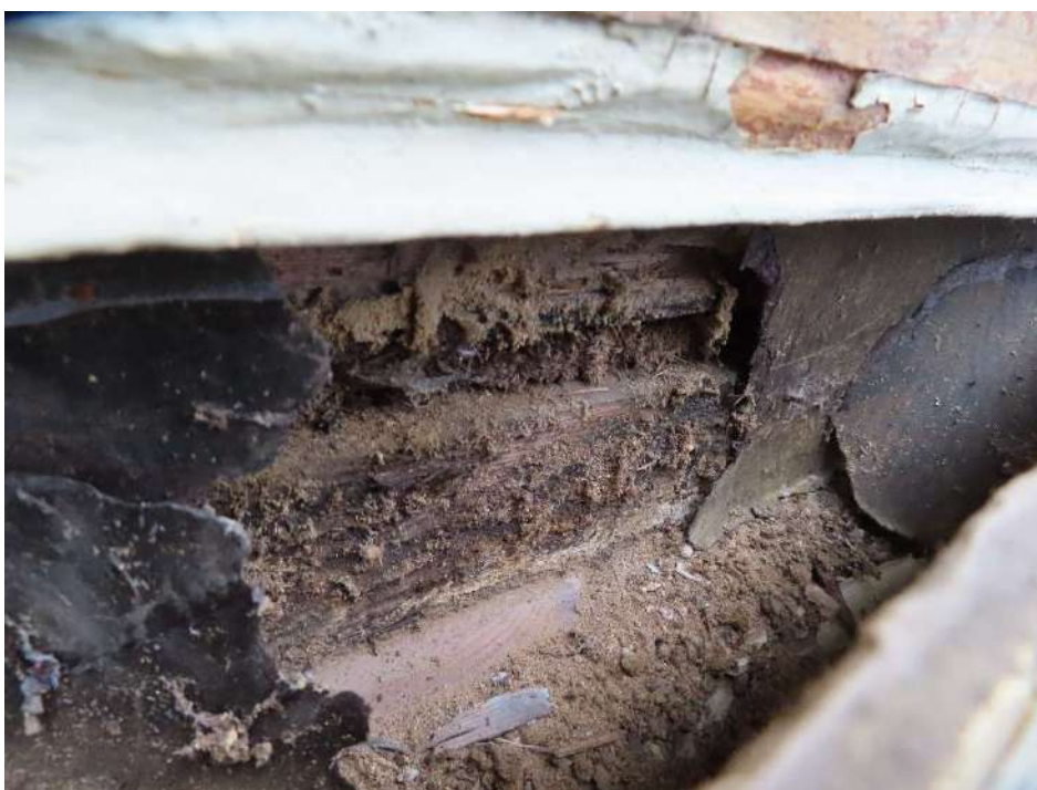
16. Sodybos name po dailylentėmis įrengtas ruberoido sluoksnis neleidžia sienojų medienai kvėpuoti, tarp sienojų ir ruberoido sluoksnio kaupiasi drėgmė, taip pažeisdama medines sienų konstrukcijas.
