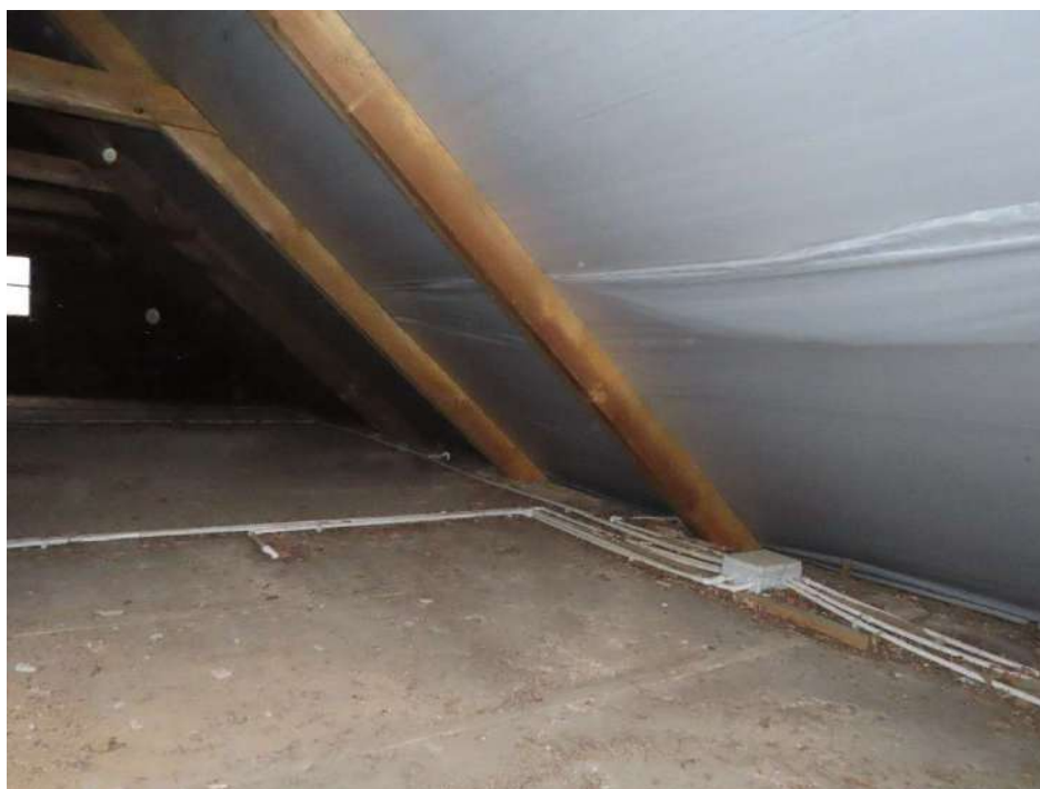
22. Ant perdangos įrengtas t=35 mm storio molio užpildas tarp medinių 80(h)x45 mm sijų.
