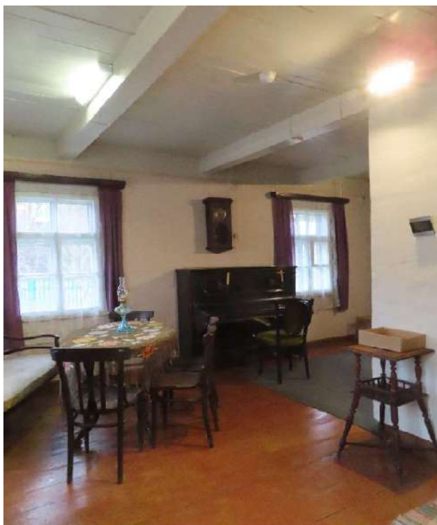
21. Aukšto perdanga medinių perdangos sijų 190(h)x150 mm išdėstytų \sim 1,4 \div 1,5 m žingsniu. Ant perdangos sijų įrengtas t=35 mm storio lentų paklotas.
