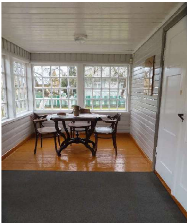
8. Verandos patalpoje grindys išklotos t=32\text{mm} storio medinėmis lentomis, sienos ir lubos iškalto medinėmis dailylentėmis
