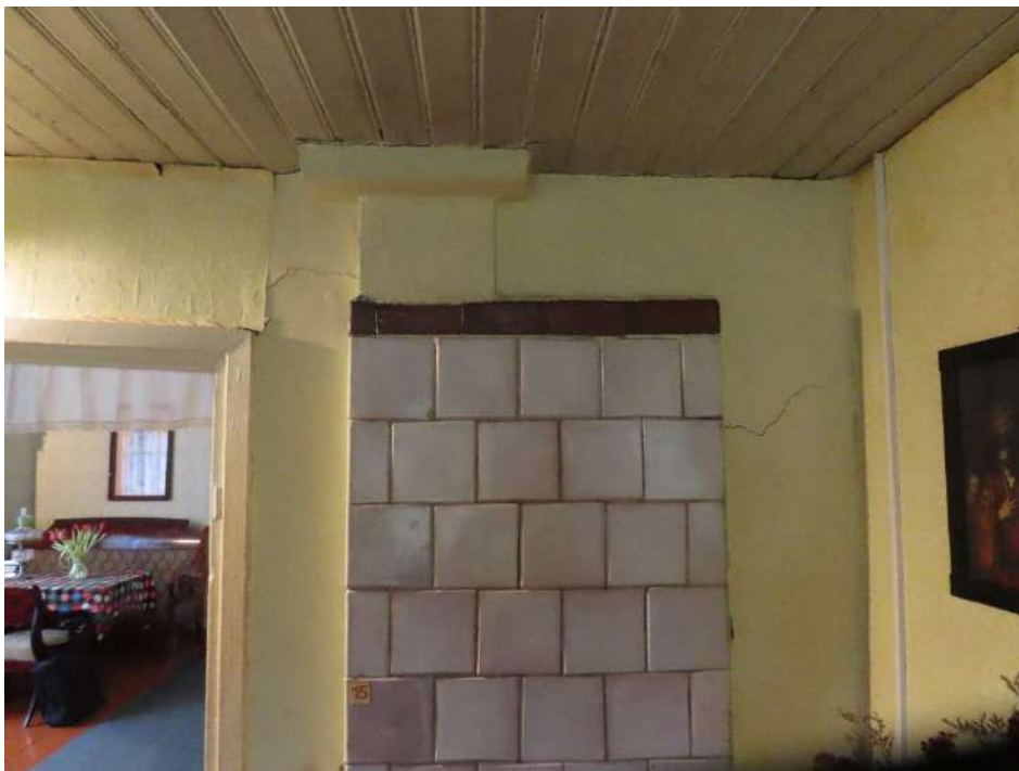
7. Mūrīnēs 0,5 plytos storio sienas mūre atsivērē horizontalūs įtrūkimai.
